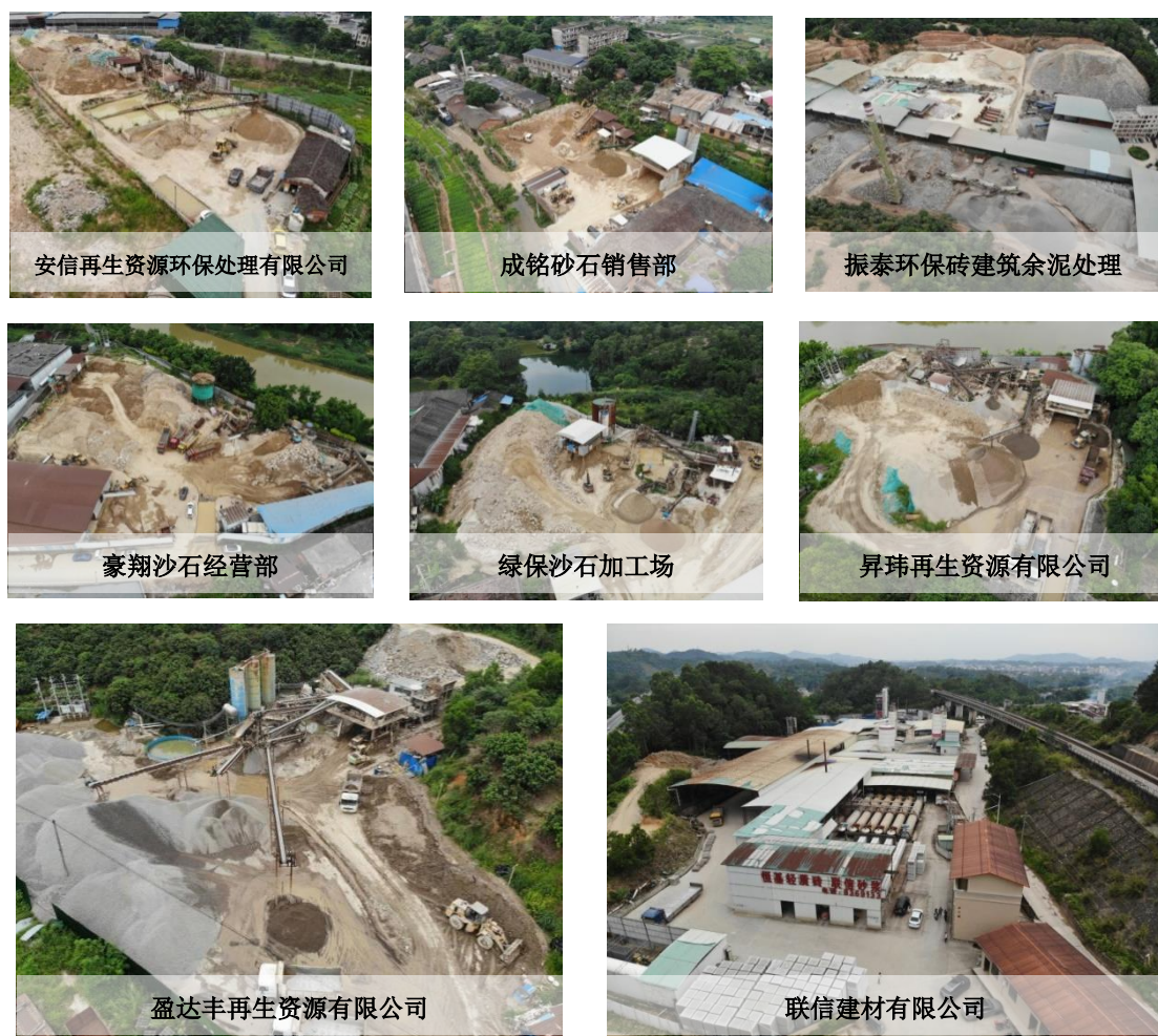
图 3-7 现状洗砂场现状图
